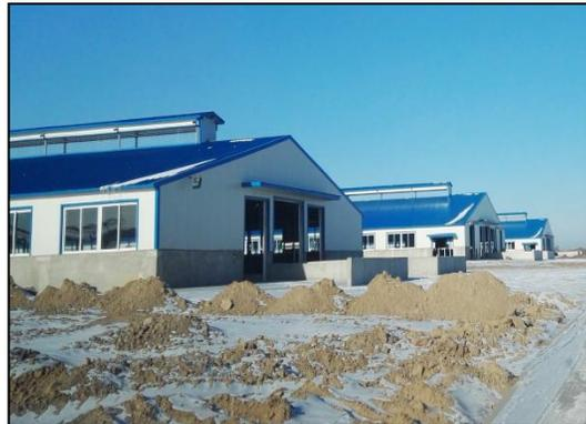
3.2 北方牛舍两端通道门建议安装电动提升或自制推拉门进行封闭，根据当地冬季温度选择门是否需要保温材料制作。
