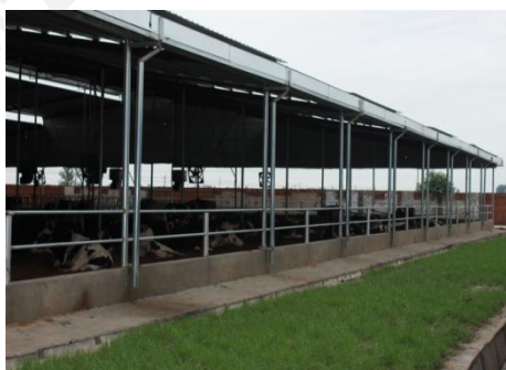
屋檐雨水导流管路
